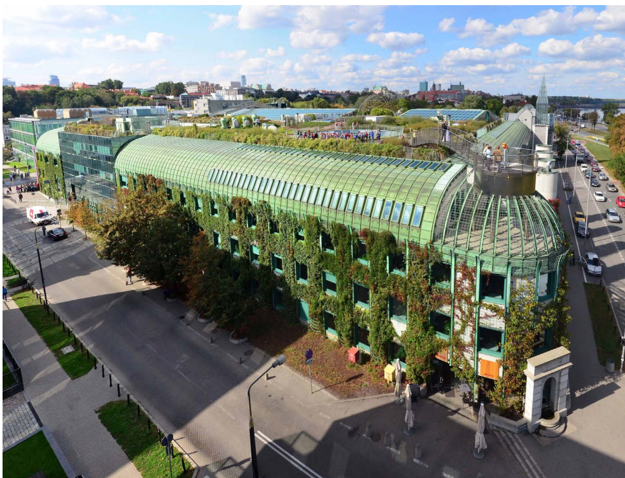
Wiele twarzy BUW-u: elewacja południowa z punktem widokowym – tzw. „belwederkiem” oraz przeszkloną plombą Wydziału Prawa i Administracji UW. Fot. Jadwiga Antoniak-Sadlakowska.
